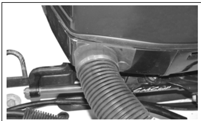
Flexible conduit installation
